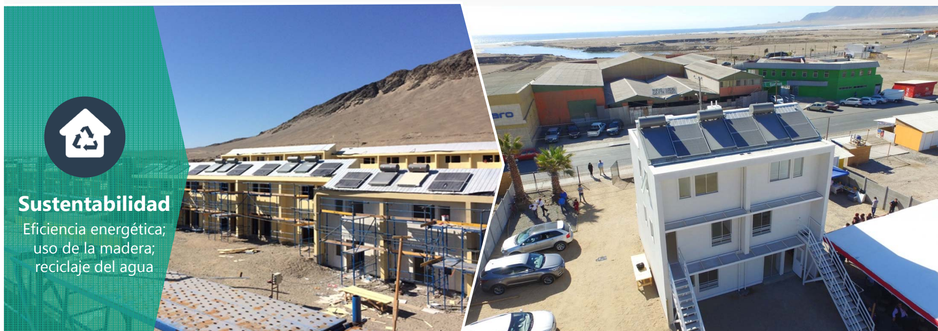
Paneles solares en conjunto habitacional en la Región de Atacama
