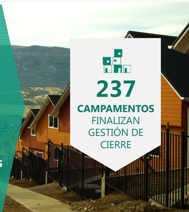
Conjunto habitacional Divisadero, Región de Aysén
