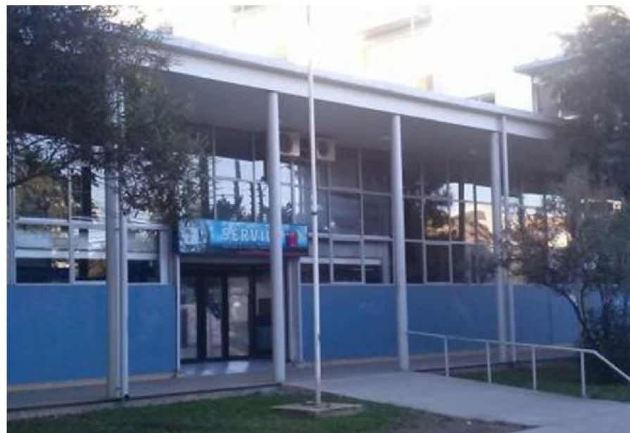
2 Oriente #925 Edificio Institucional
